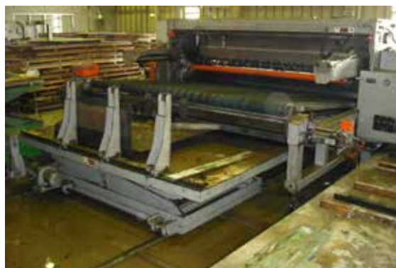
シャーリング機ピット (7/16)
