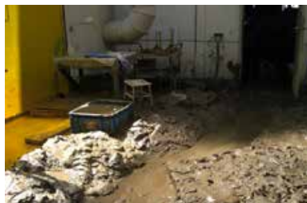
汚泥が押し寄せた新工場裏 (7/17)
