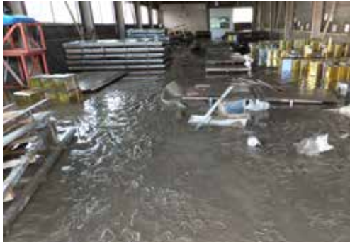
旧 9 番工場 建築金具置き場 (7/16)
